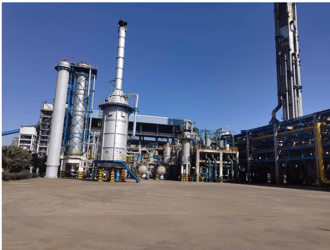
图 F1-5 甲醇中间罐东面（合成氨装置）
