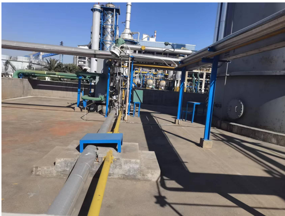
图 F1-1 甲醇中间罐搬迁位置
