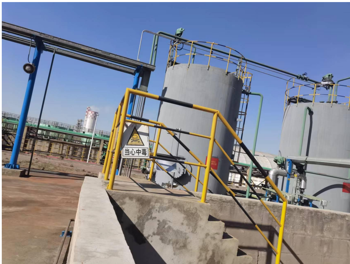
图 F1-3 甲醇中间罐北面（脱盐水箱、隔路为高压消防水站）
