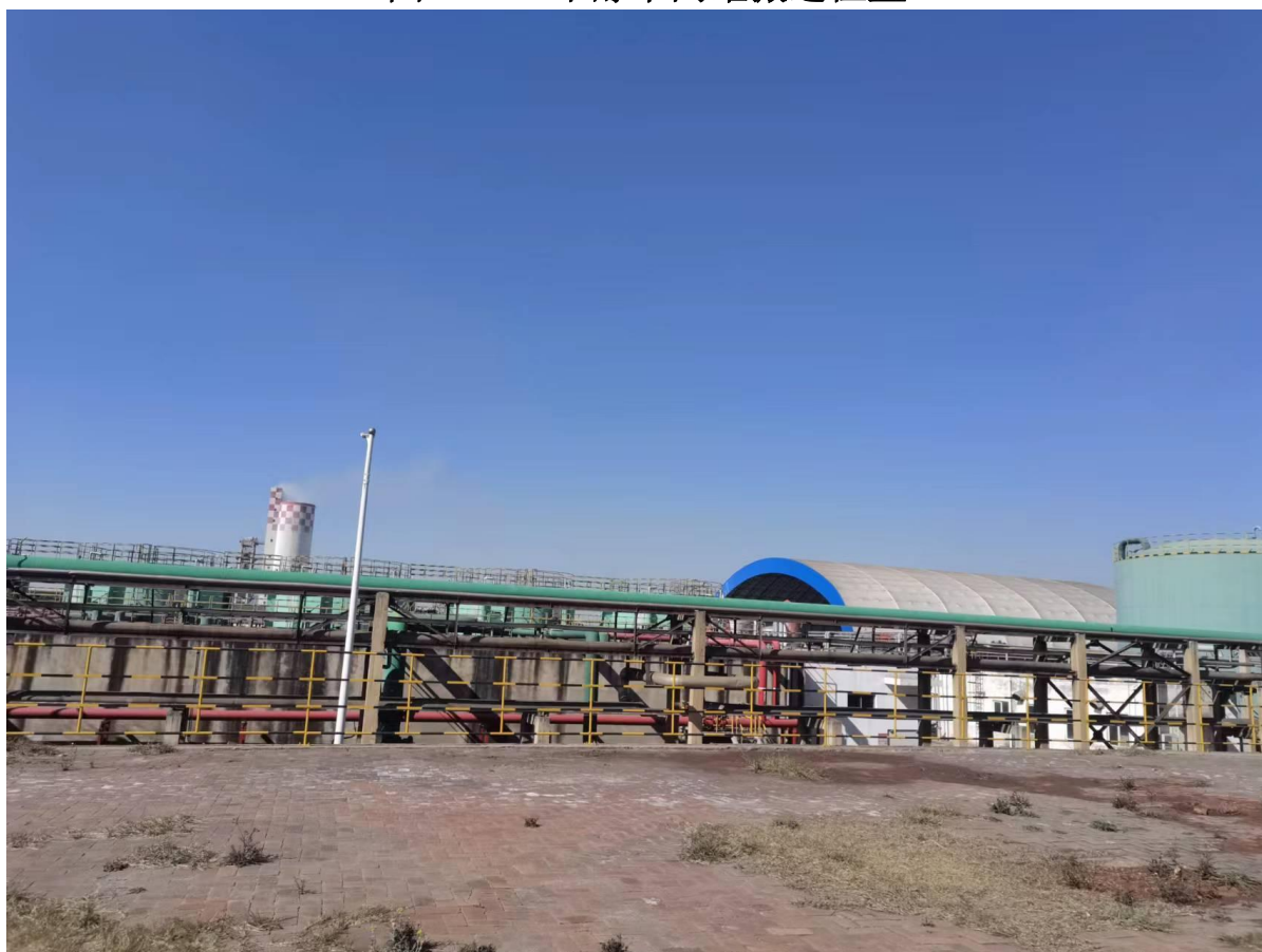
图 F1-2 甲醇中间罐西面（厂区次要道路）
