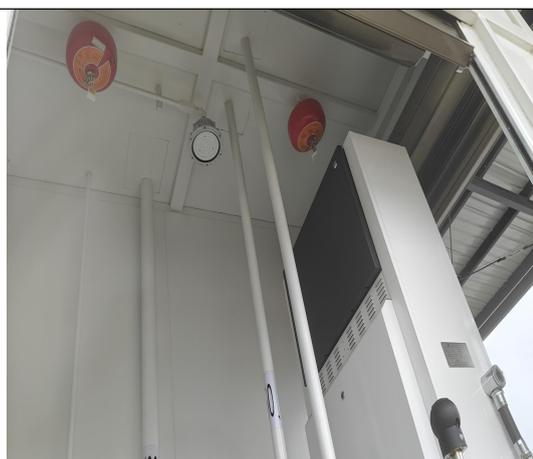
图片 4 加油机上部自动灭火器
