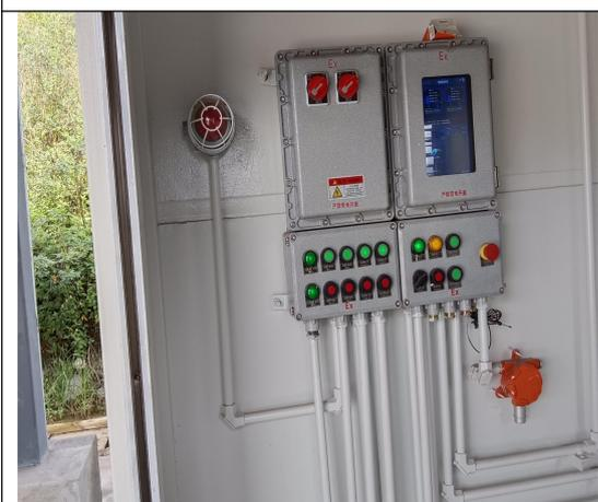
图片 5 紧急切断系统、液位监测及渗漏监测
