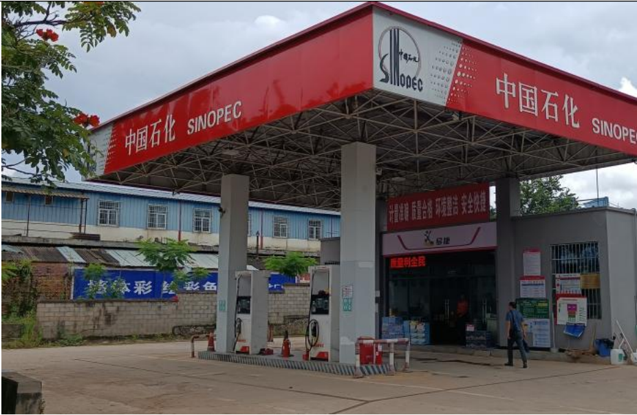
图 3 加油站加油区
