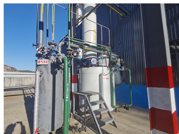
附图 9 煤气和尾气水封
