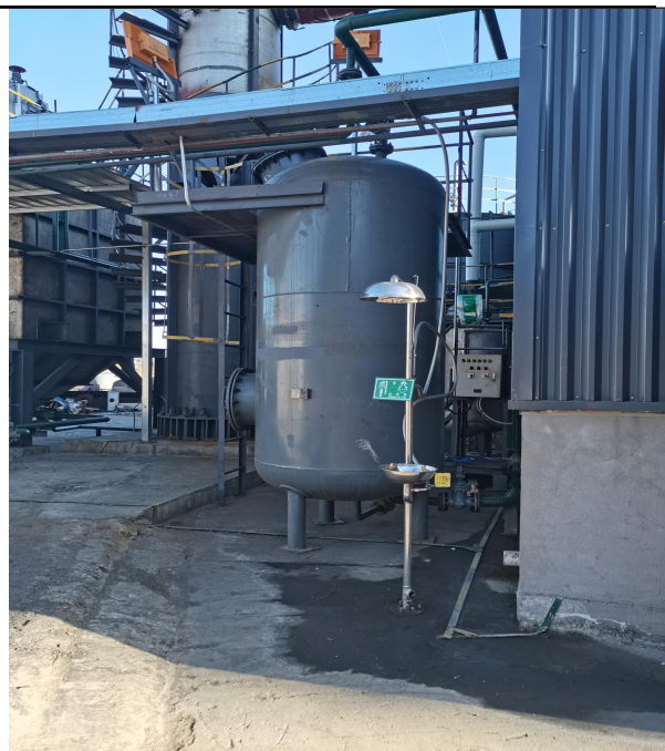
附图 12 石英砂过滤器、洗眼器
