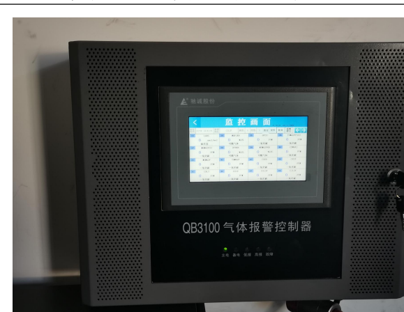
附图 14 可燃、有毒气体泄漏报警控制器
