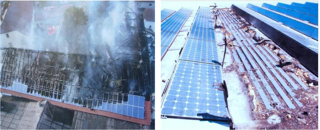
图 3.6-1 光伏屋顶的太阳能组件“自燃”图 3.6-2 屋顶太阳能光伏电站“自燃”现场
