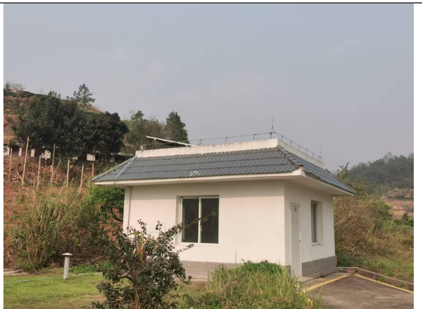
图 20 水泵房顶光伏组件
