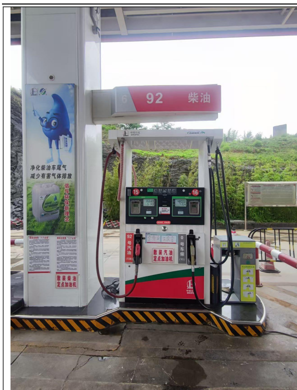
图 7 92#汽油、0#柴油加油机
