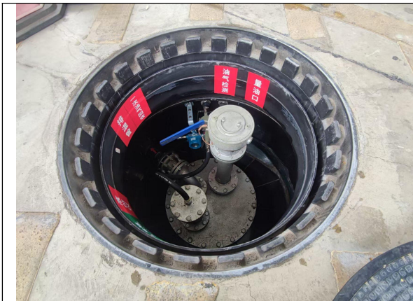
图 21 量油孔操作井
