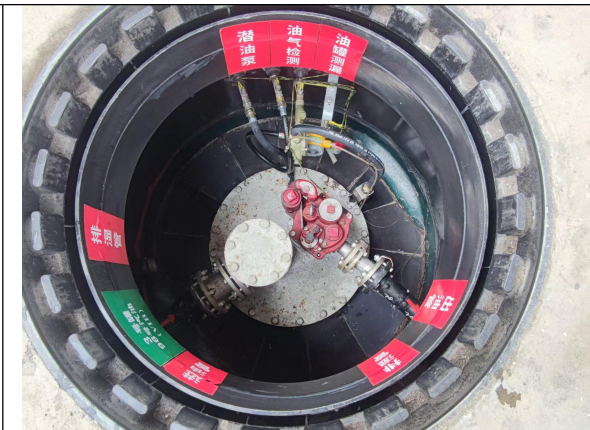
图 22 潜油泵操作井
