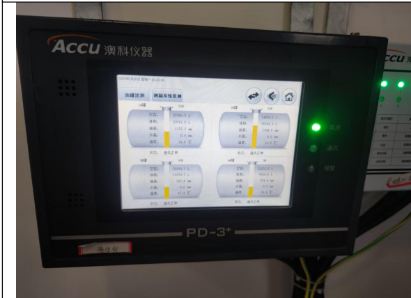
图 23 液位、管线监测器
