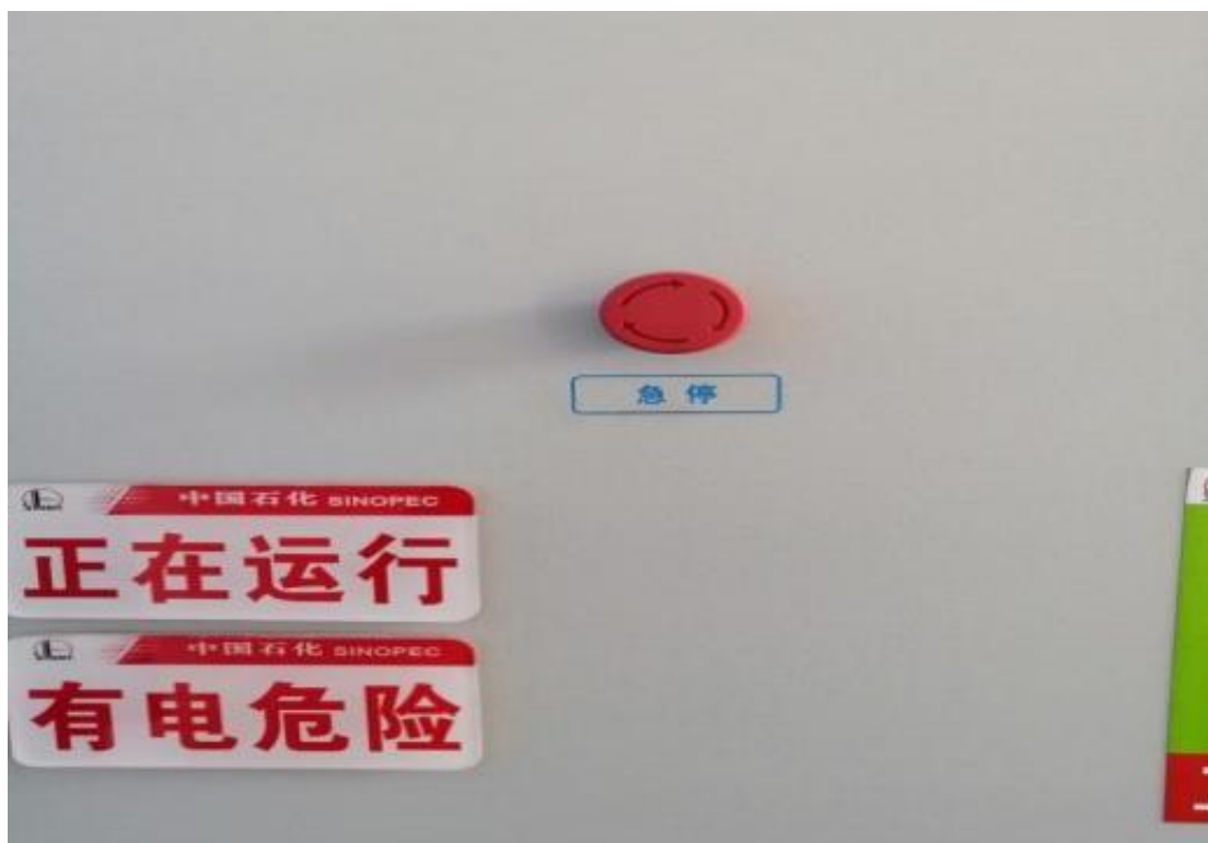
图6-10设置在站控室的紧急切断阀
