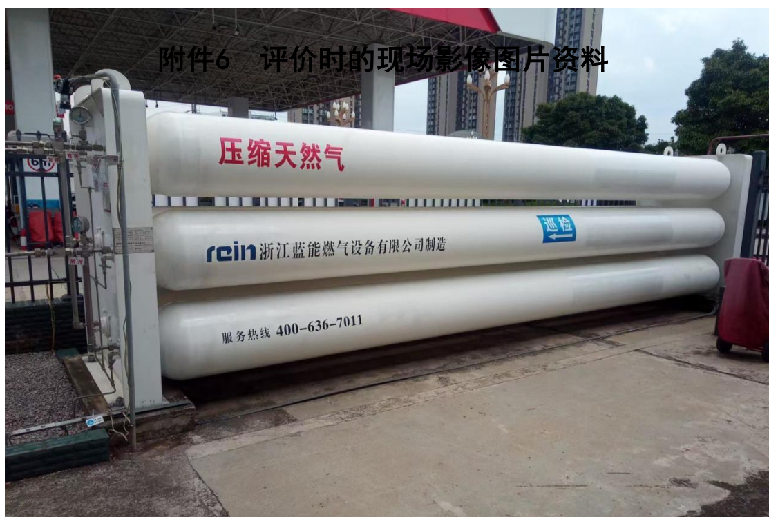
图6-1 CNG储气瓶组
