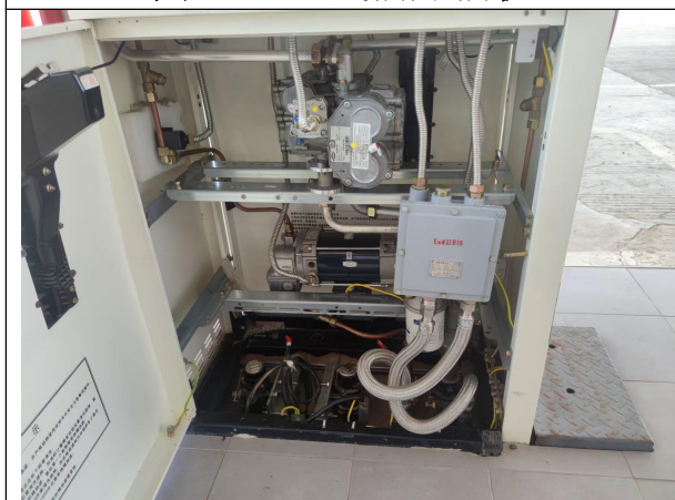
图 9 加油机内部结构
