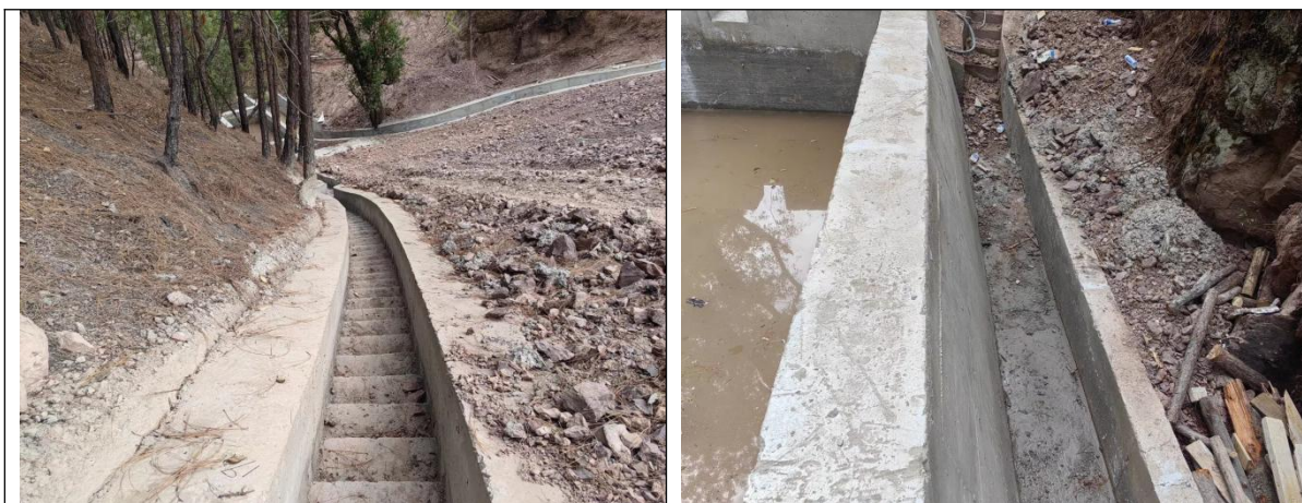
图 2-19 左岸坝肩排水沟竣工现状图
