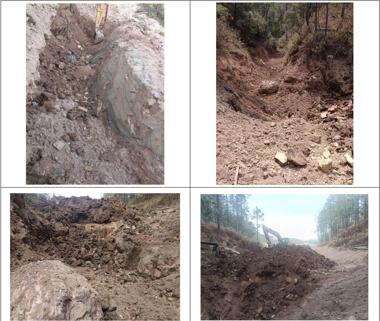
图2-5 库尾清淤工程照片
