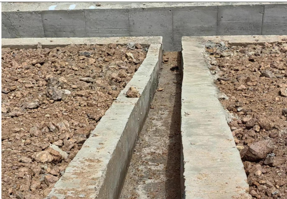
图 2-33 坡面雨水沟图
