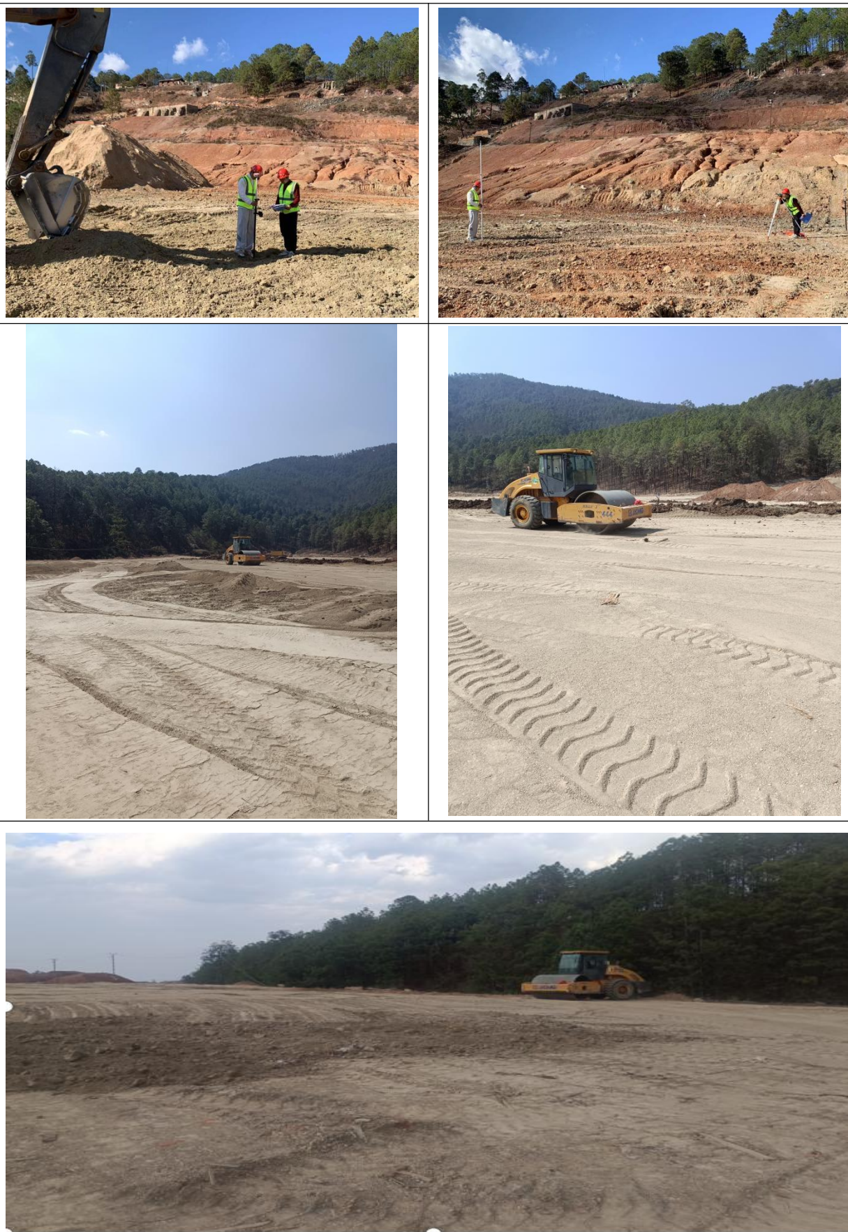
图2-4 滩面平整压实照片
