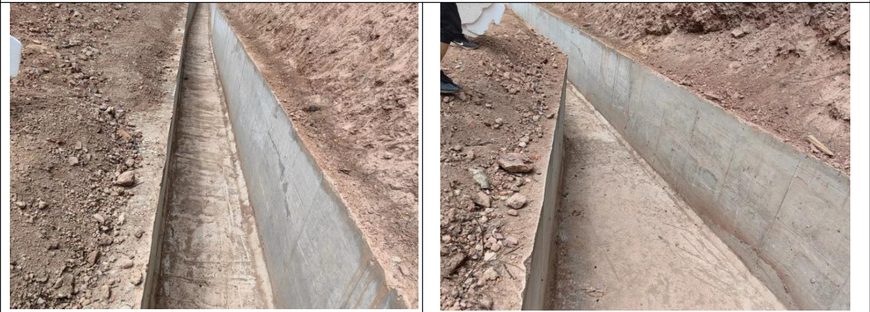
图 2-27 Y0+000.00-Y0+214.79 段浇筑完成照片
