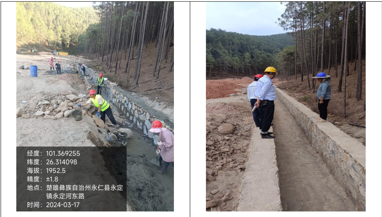
图 2-22 M 7.5 M u40 浆砌石结构
