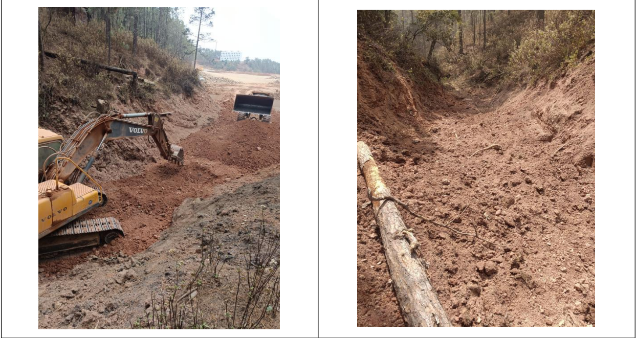
图2-6 库尾土方换填照片
