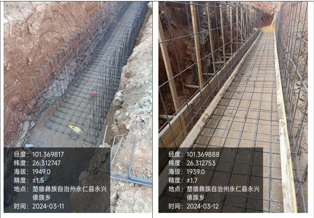
图 2-26 Y0+000.00-Y0+214.79 段钢筋施工现场照片
