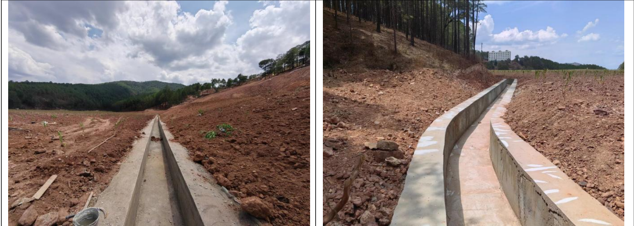
图 2-22 M 7.5 M u40 浆砌石结构
