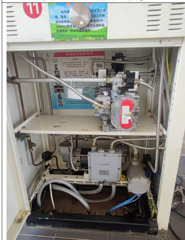
图 11 加油机内部结构
