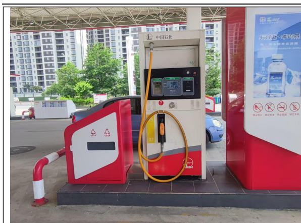
图 7 95#汽油加油机
