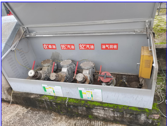
图 9 油罐卸油口
