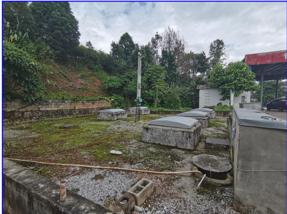
图 10 埋地油罐罐池
