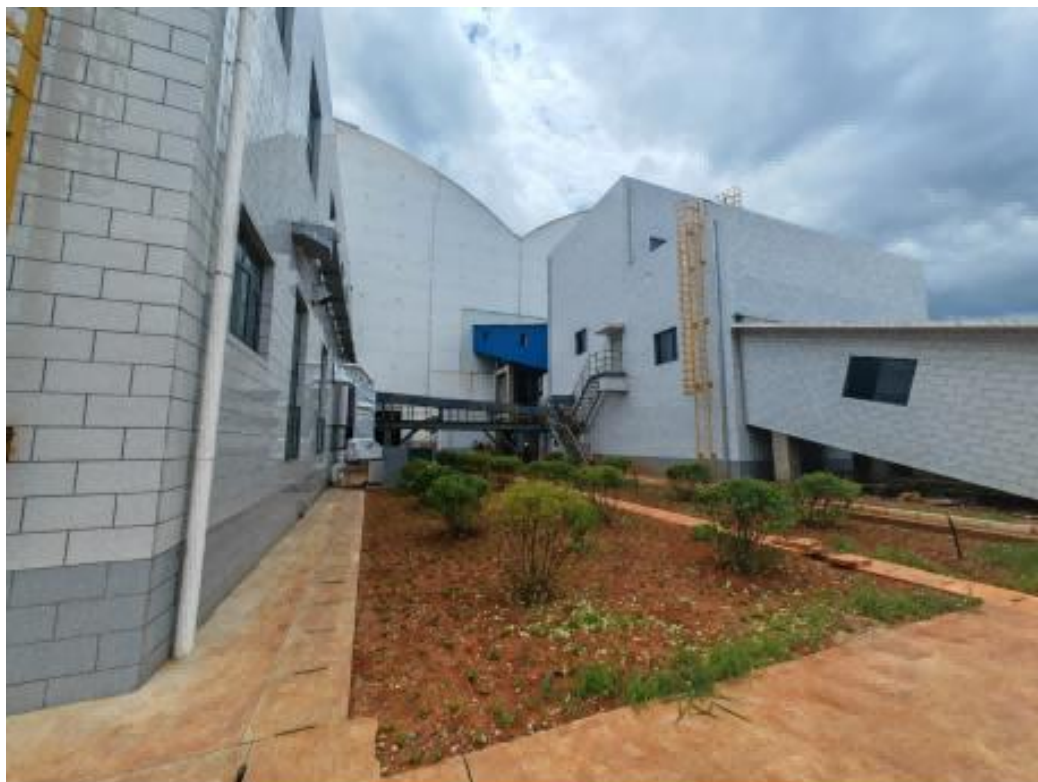
附图 1-4 小试楼北面——采样除铁间
