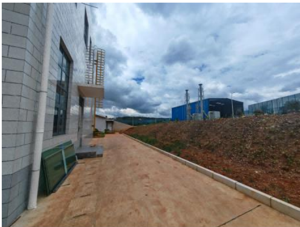
附图 1-3 小试楼西面——煤棚
